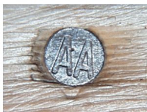
Abb.: 10: Nagelbild „zugelassene Nägel“
